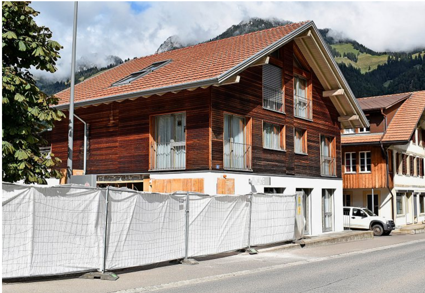
Die Räumungsarbeiten sind im Gange: Das Gebäude der AEK-Bank in Oey nach der Bancomat-Sprengung vom Montag. Foto: Sandro Huber
